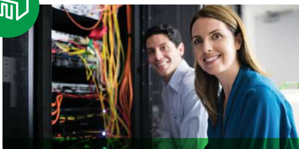
SERVIDORES DE ENTRADA E PEQUENOS DATA CENTERS
